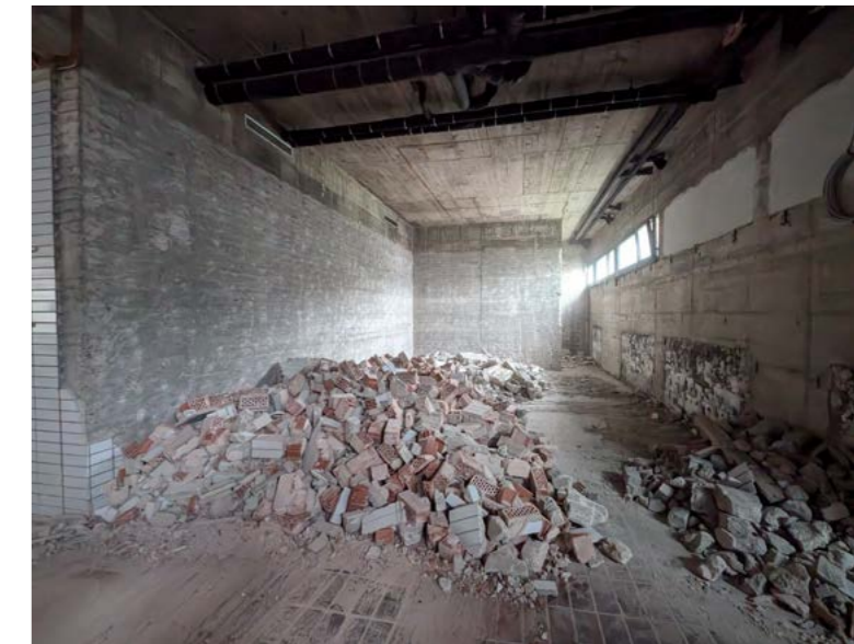
Abb.: Bauarbeiten in der ehemaligen Schwimmhalle
