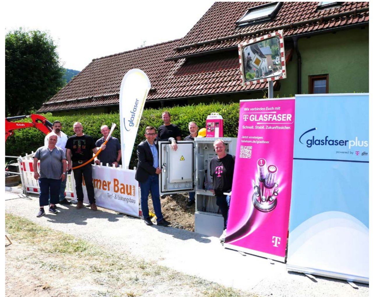
Abb.: Spatenstich Glasfaserausbau
