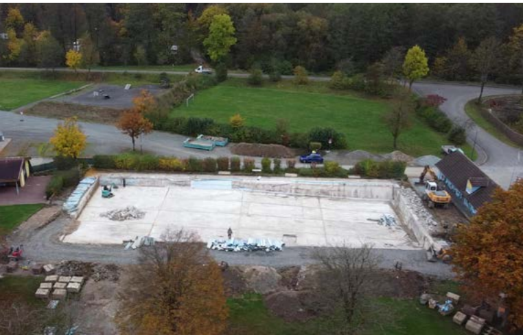
Abb.: Baustellenarbeiten Freibad Wallenfels
