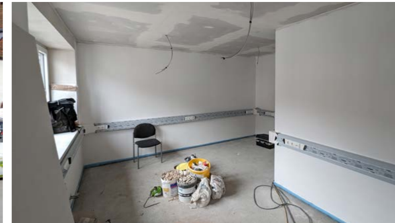
Abb.: Baustelle Marktplatz 11
